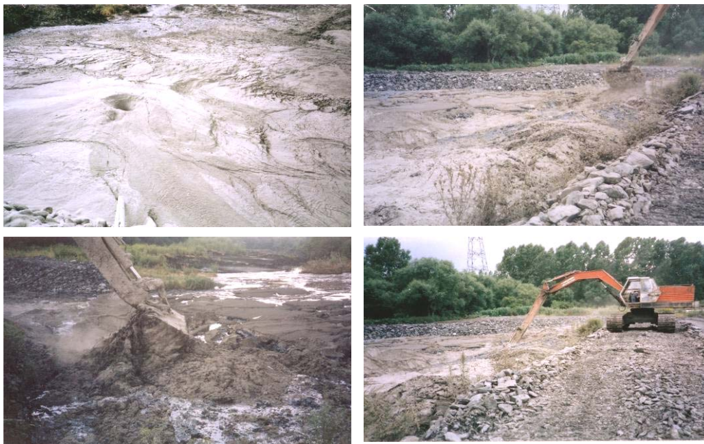
Figure n°: 4 Dépotage des cendres sèches et mélange avec les boues
