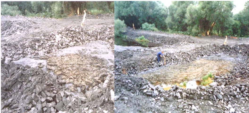
Figure n°: 2. a. et 2.b. Les travaux de remblayage de bassin 1
