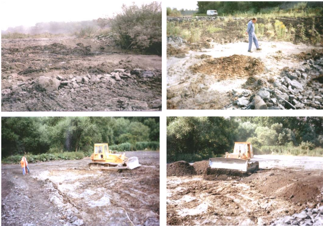
Figure n°: 5 Solidification et recouvrement par schistes fins
