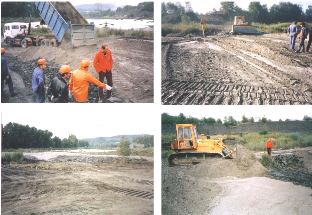
Figure n°: 6 Travaux de couvert par de cendre humides
