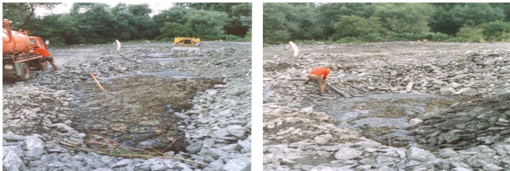
Figure n°: 3 Remblayage progressif, une partie des boues s'infiltrer entre les cailloux
